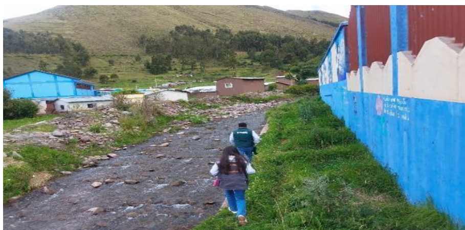
FIGURA N°03: SE APRECIA EL CAUCE DE LA QUEBRADA KUMUYAPU, ALEDAÑOS AL CAUCE SE LOCALIZA AREAS DE CULTIVOS Y VIVIENDAS ASENTADAS, LOS CUALES SE ENCUENTRAN EXPUESTOS EN PELIGRO INMINENTE AL SER AFECTADOS POR LAS PROXIMAS AVENIDAS DEL RIO.
